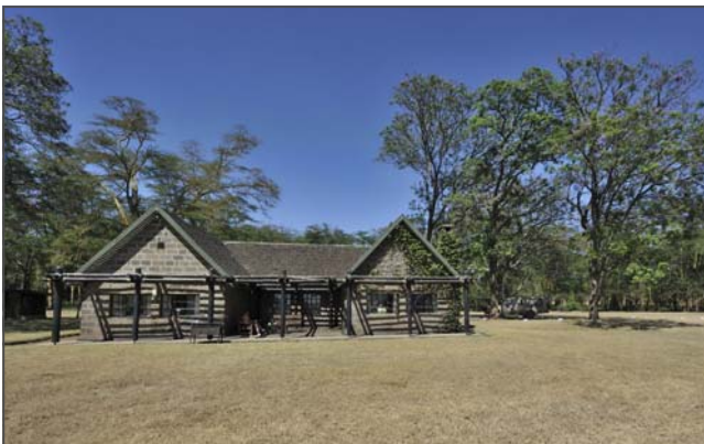
Naishi Guest House, au milieu du Parc National de Nakuru
